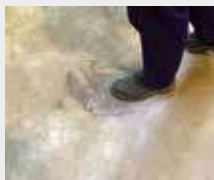
Applicazione di C-DUST in ambiente di lavoro pedonabile.
